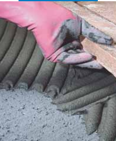
Het aanbrengen van handgemaakte cotto op een losse dekvloer
