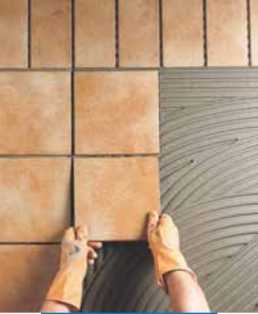
Het buiten aanbrengen van klinkertegels
