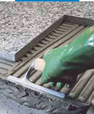
Het buiten leggen van terrazzo met grind, voorzien van reliëf
