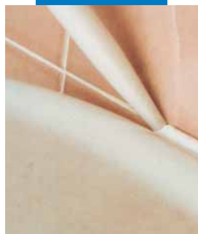
Afdichten van sanitair
