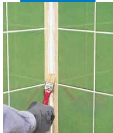
Het met zeepwater en een kwastje gladmaken van de voeg
