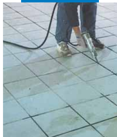
Afdichten van een keramische vloer met Mapesil AC
