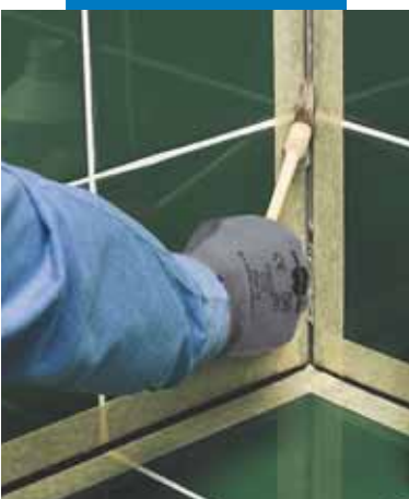
Aanbrengen van Primer FD
