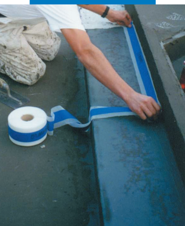
Voorbeeld van het waterdicht maken van een hoek tussen de bodem en een deel van een badkuip met Mapeband
