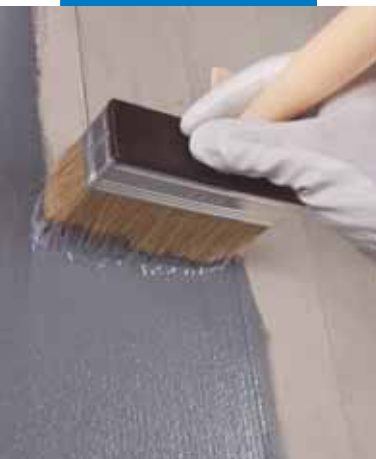
Met een kwast aanbrengen van Eco Prim Grip op een betonnen ondergrond
