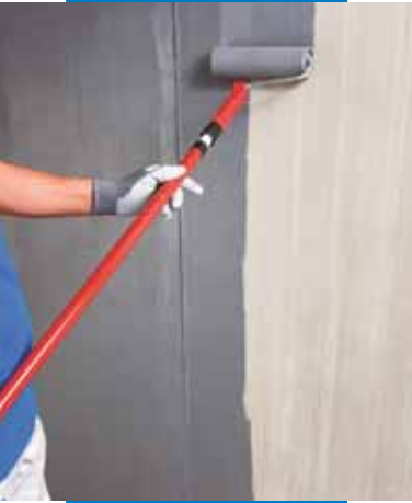
Met een roller aanbrengen van Eco Prim Grip op een betonnen ondergrond
